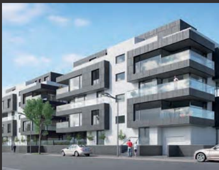
APPARTEMENT À LUXEMBOURG-BEGGEN APARTMENT IN LUXEMBOURG-BEGGEN
